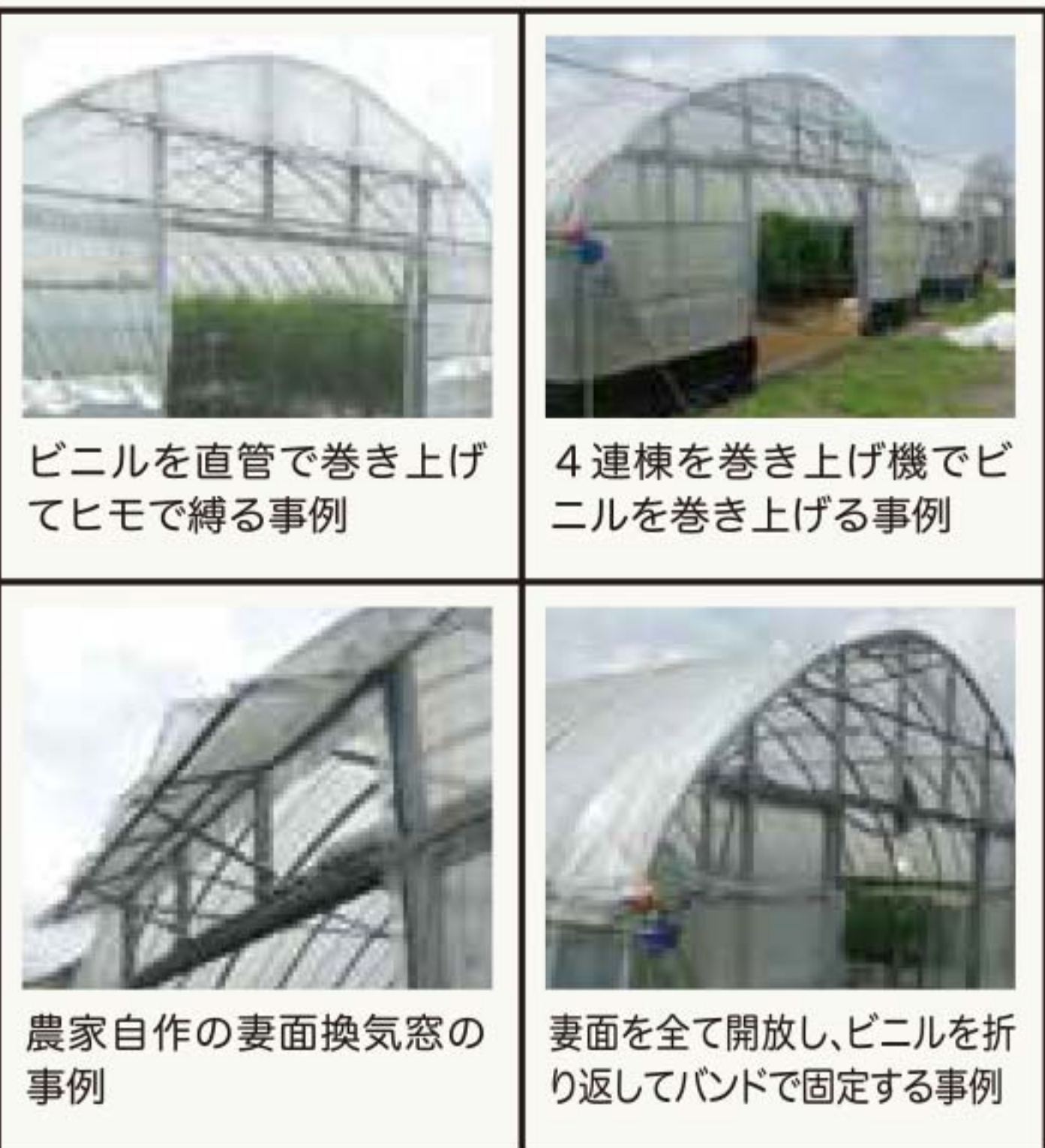
図2 妻換気の工夫事例
